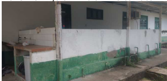
FOTO 07: REFEITÓRIO – INSTALAÇÕES EXTERNAS DE APOIO
