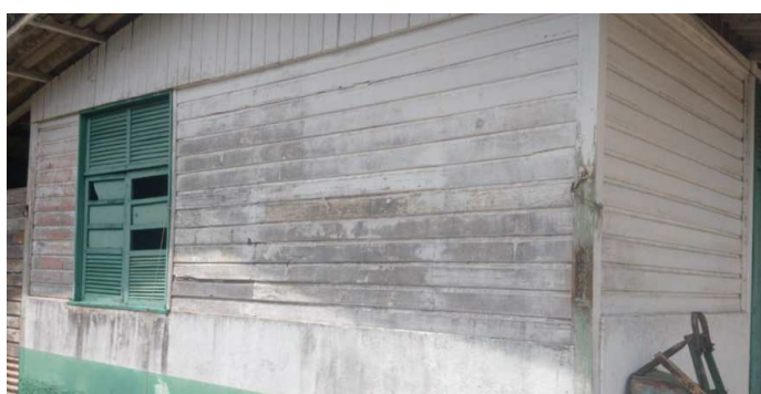
FOTO 11: ALMOXARIFADO – ESTADO DE CONSERVAÇÃO EXTERNA
